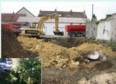
Chantier Seine et Marne
