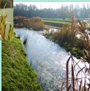
Station d'épuration Honfleur(14)
