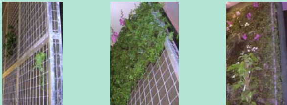
Mise en place des végétaux sur la structure du mur filtrant
