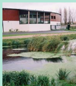
Vue extérieure de la serre filtrante d'Honfleur
