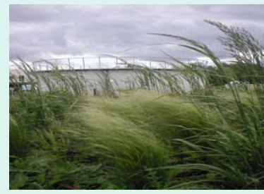
Jardins Filtrants® Air station d'épuration d'Alençon
